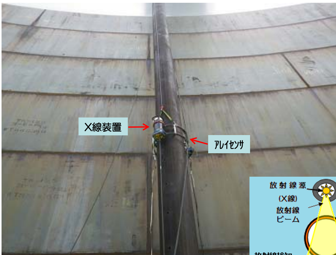
ゲージポールの腐食検査状況
