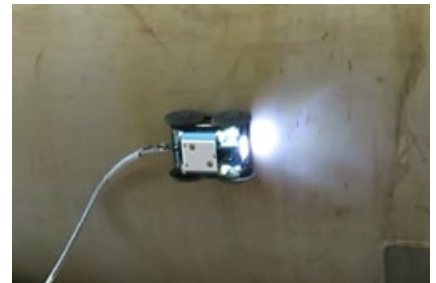
配管外面走行
