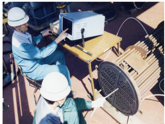
現場での探傷状況
