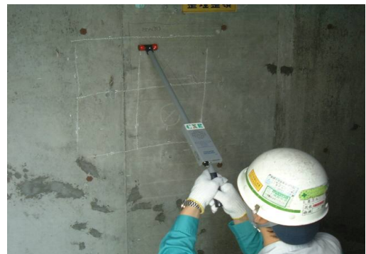
埋設ケーブル探索状況
