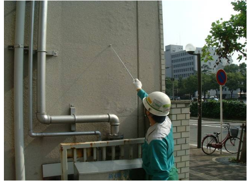
打音調査状況
