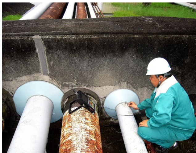
防油堤貫通部の配管腐食調査状況
