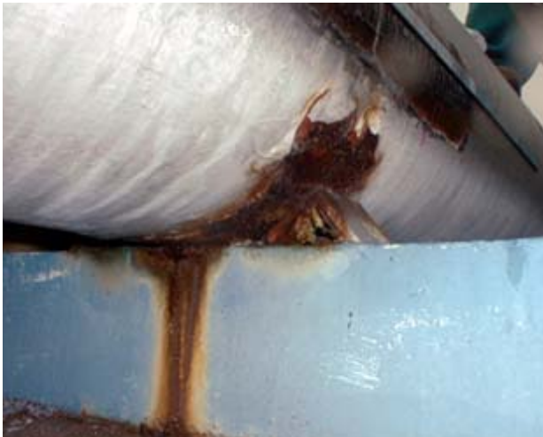
架台接触部配管の施工状況
