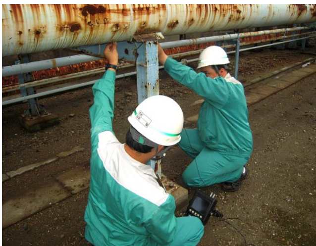
架台接触部の配管腐食調査状況
