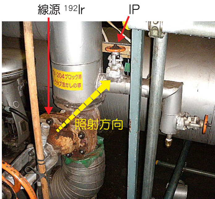
IPを使用した保温材下小径管の撮影状況
