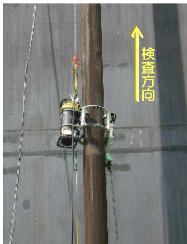
原油タンクガイドポール検査例
