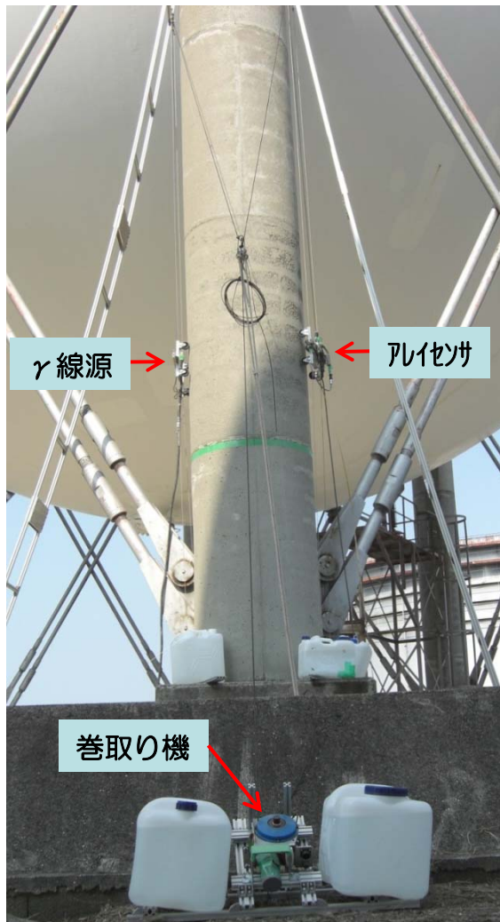
球形タンク脚柱の腐食検査状況
