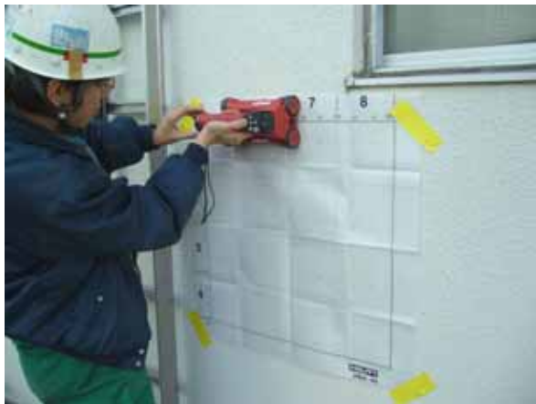
コンクリート内部探査状況
