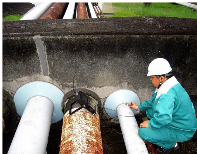
防油堤貫通部の配管腐食調査状況
